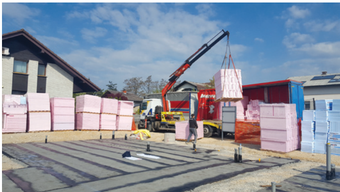
Slika 3: Priprava podlage in dostava elementov
