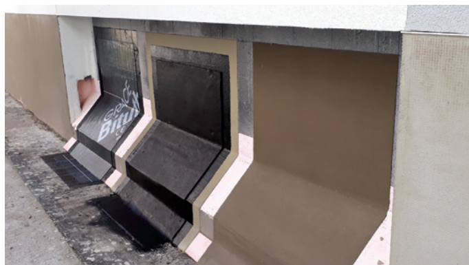
Slika 7: Vzorci hidroizolacij podzidka
