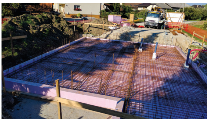
Slika 5: Montaža armature
