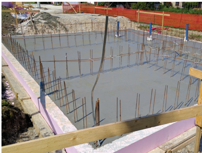
Slika 6: Vgrajeni beton
