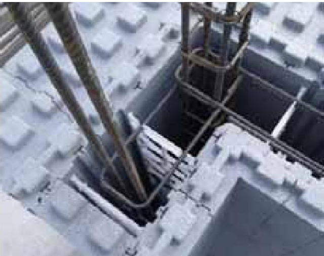
Slika 6 • Minimalno armiranje velikih šibko armiranih sten.
