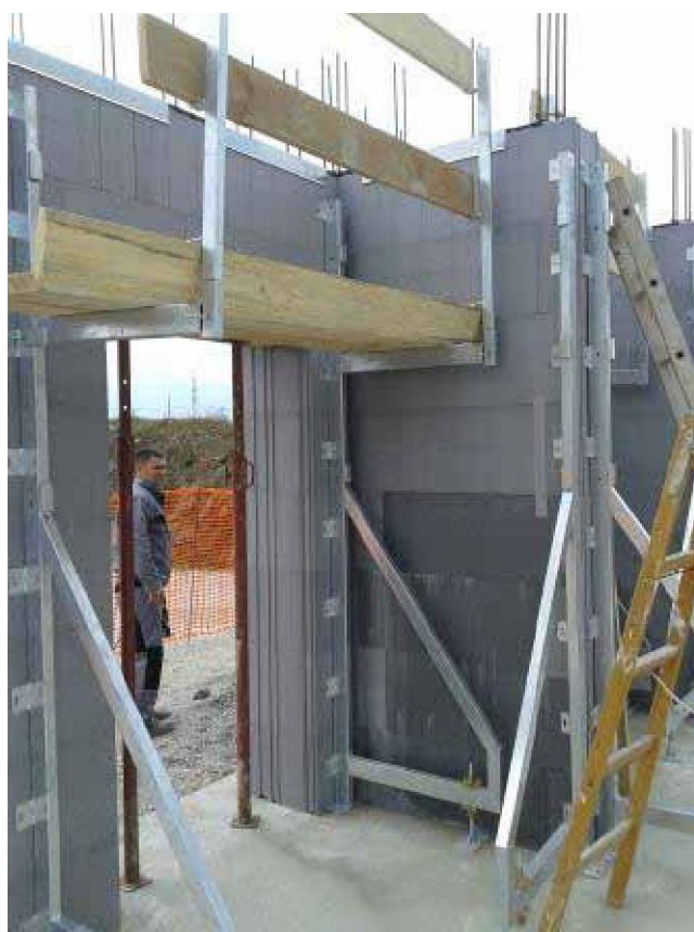
Slika 7 • Sistemske komponente JUBHome WALL.
