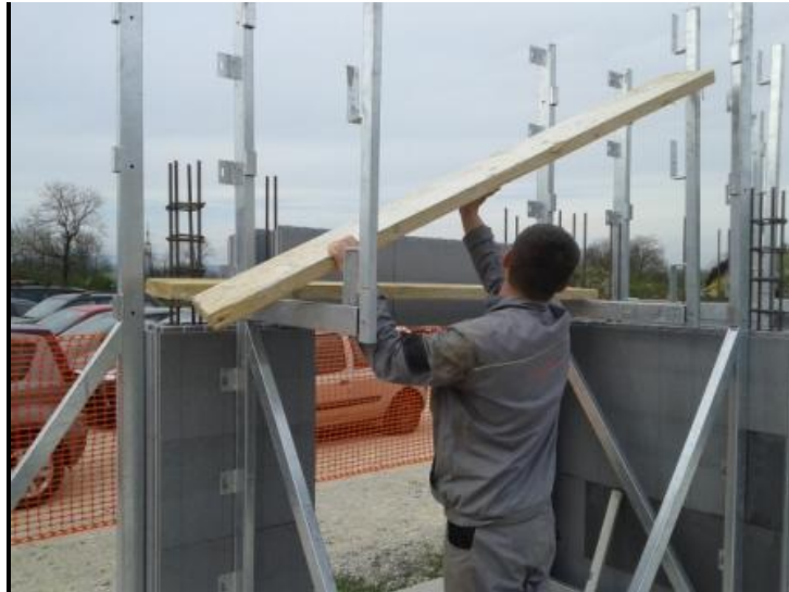
Slika 12: Montaža poda iz plohov
