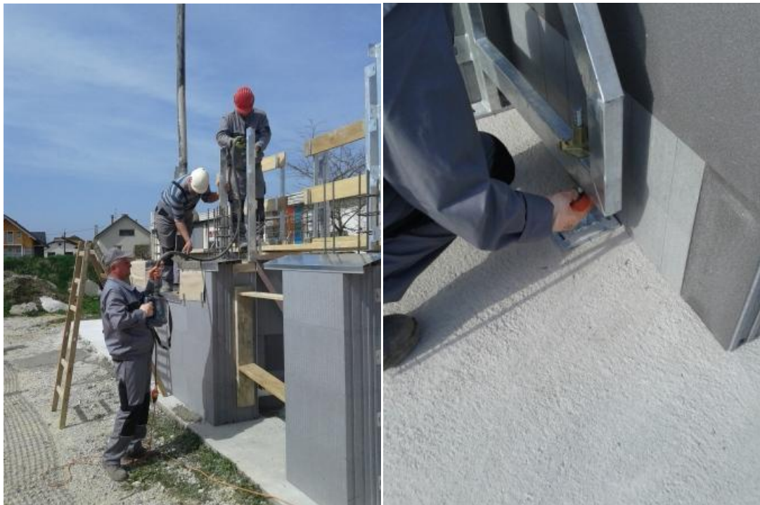
Slika 14: Betoniranje in popravilo vertikalnosti z regulacijskim nastavkom
