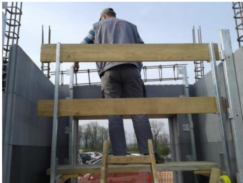
Slika 15: Montaža oblikovnikov in armature zgornjega dela stene
