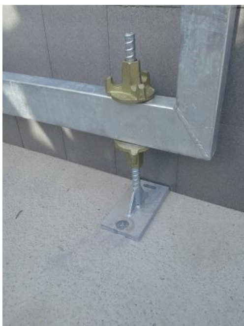
Slika 4: Postavitev vijlačnega nastavka
