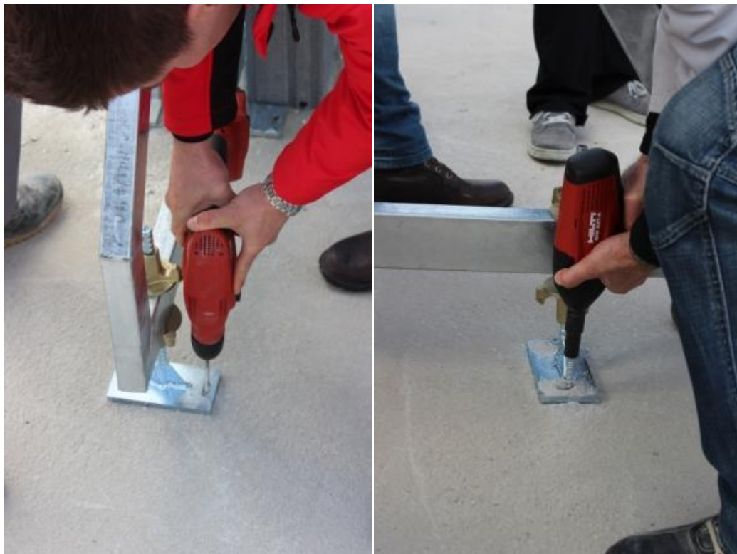
Slika 7: Pritrditev opore (vrtanje, vijačenje)
