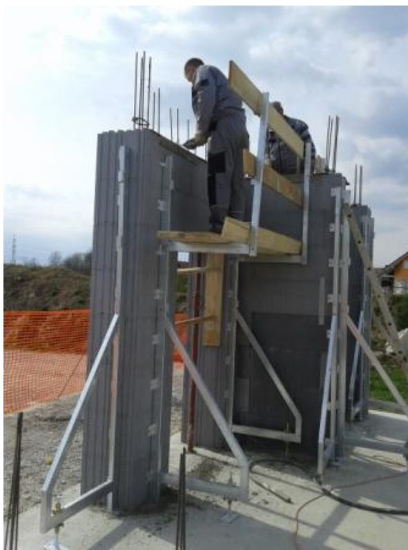
Slika 20: Delo s povišanega delovnega poda
