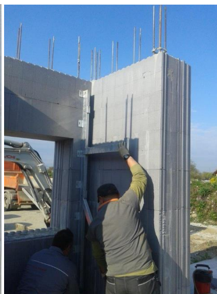
Slika 25: Pridrževanje opore
