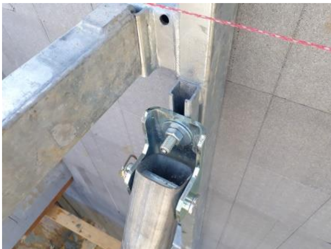
Slika 22: Pritrditev s kladivastim vijakom
