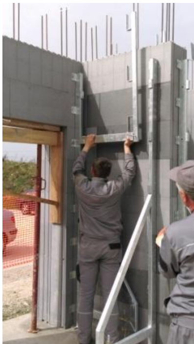
Slika 16: Montaža prečke zgoraj
