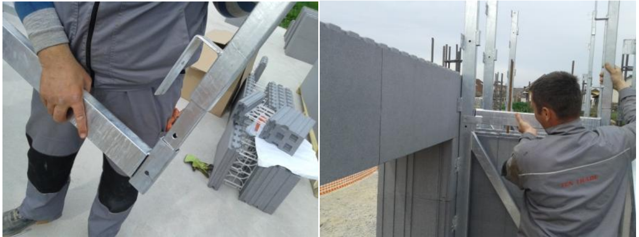
Slika 9: Sestavljanje stebra ograje in prečke, natikanje na steber
