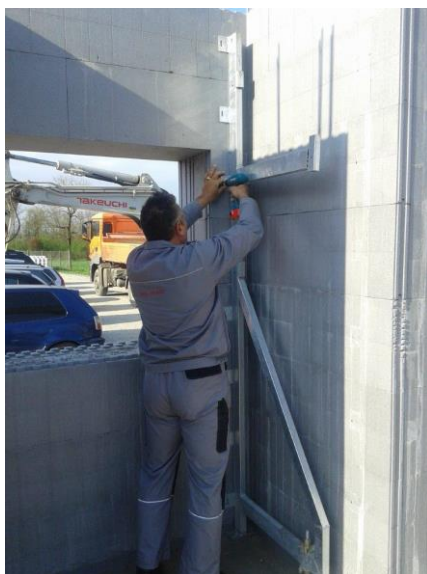
Slika 24: Odstranitev vijakov opore
